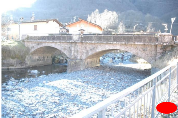
Ponte della S.P. 49 sul Torrente Fiumenero
