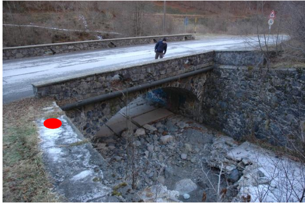
Ponte della S.P. 49 sulla Valle Antica
