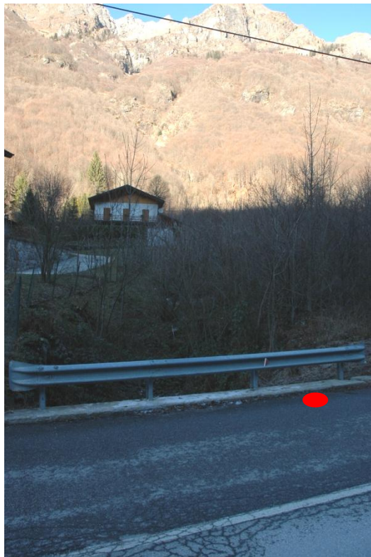
Ponte della S.P. 49 su alveo abbandonato
