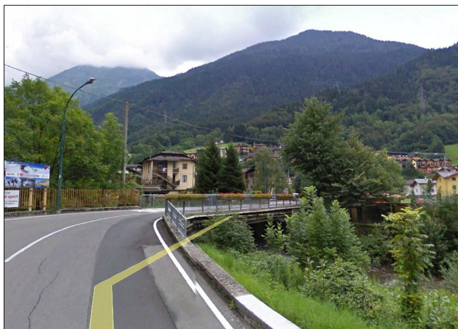
Figura 5 - Valbondione, ponte principale di accesso al paese lungo Via San Lorenzo
