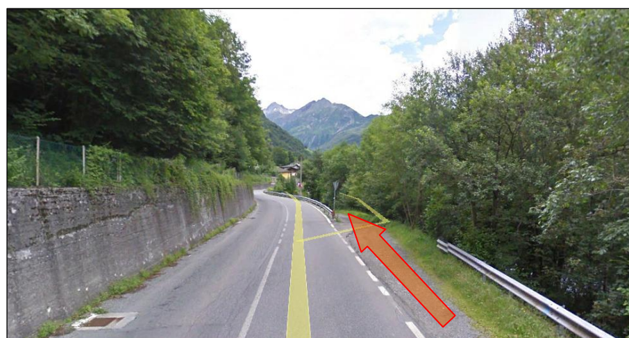
Figura 23 - Gavazzo, Strada Provinciale n. 49, ingresso alla ciclovia da strada sterrata laterale
