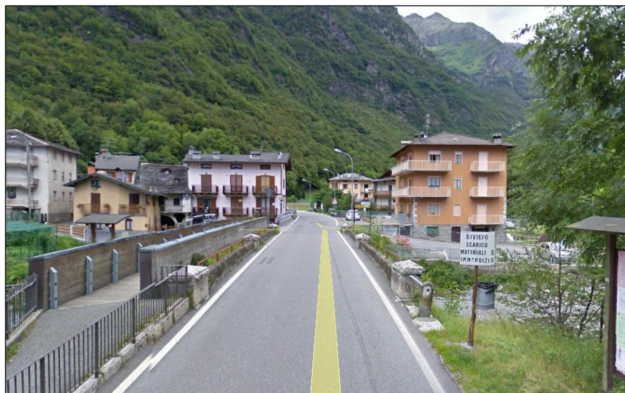
Figura 6 - Fiumenero, ponte della S.P. 49 sul Torrente Fiumenero
