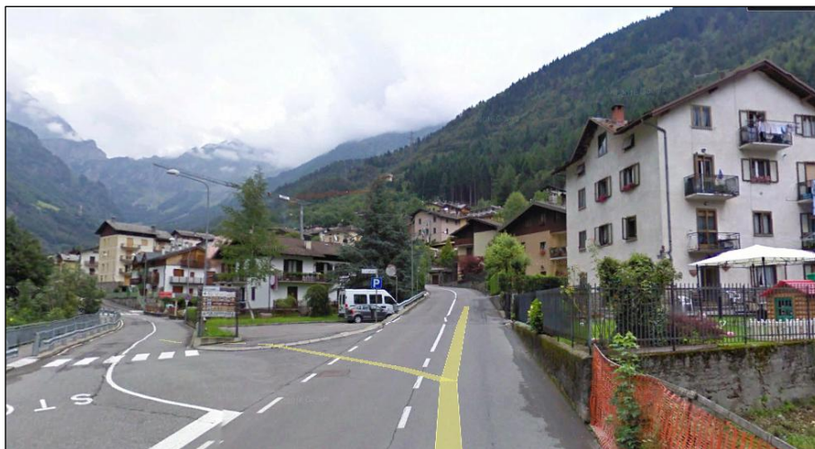
Figura 2 – Via Tarcisio Pacati, strada d'accesso alla frazione Lizzola da Valbondione
