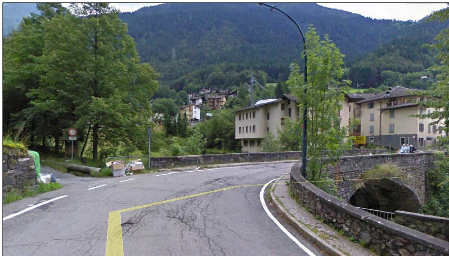
Figura 37 - Ponte di Torre, accesso alternativo all'abitato di Valbondione
