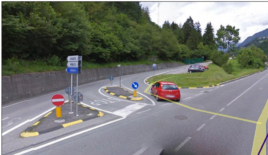
Figura 11 - Strada Provinciale n. 49 e imbocco della S.P. n. 49bis
